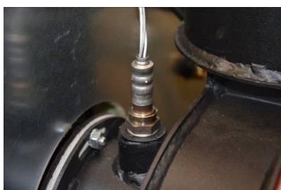
Slika 43: Lambda sonda - senzor preostalega kisika v dimnih plinih
