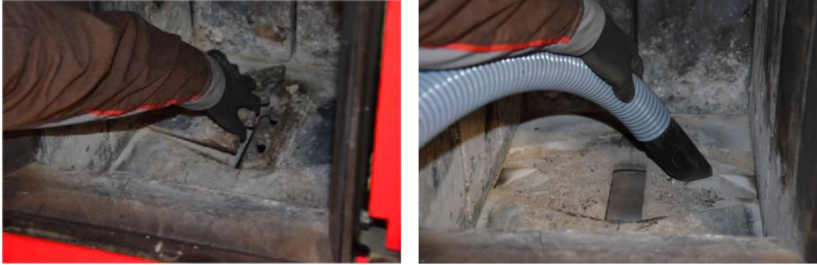
Slika 46: Odstranitev zgorevalne šobe in čiščenje dovodnega kanala za sekundarni zrak
