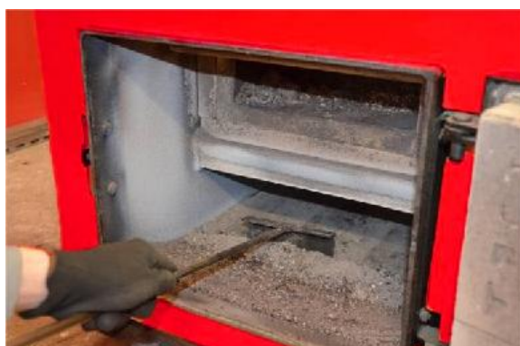
Slika 41: Čiščenje dimnega kanala
