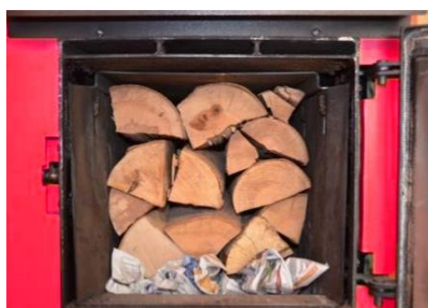
Slika 21: Primer pravilno naloženega kurišča
